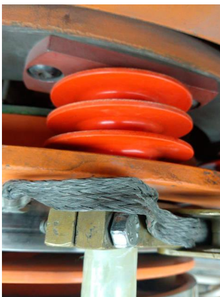
Slika 9 – Sklopljena komponenta nosača četkica nakon čišćenja.
